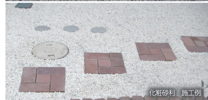
砕石6号 施工例
